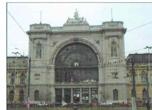
228. ábra: Budapest-Keleti pályaudvar vágánycsarnokának felújított, Baross téri homlokzata, Magyarország (1998)
