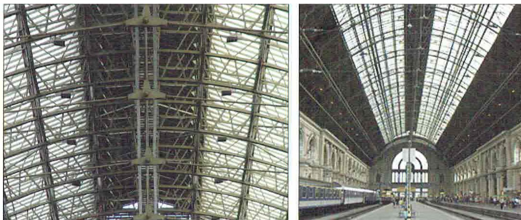
226. ábra: Budapest-Keleti pályaudvar 1998-ban felújított tetőszerkezete és vágánycsarnoka, Magyarország
