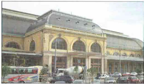
235. ábra: Budapest-Keleti pályaudvar kijárati csarnokának felújított tetőfedése, Magyarország
