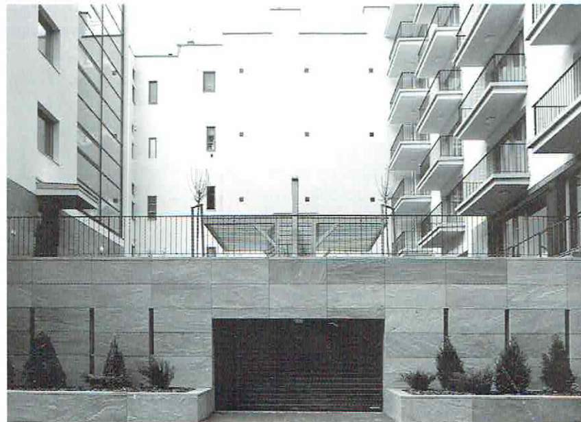
2. ábra: Gépkocsi bejáró, belső udvar
